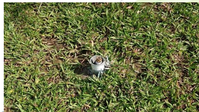
噴水頭增設硬管保護
